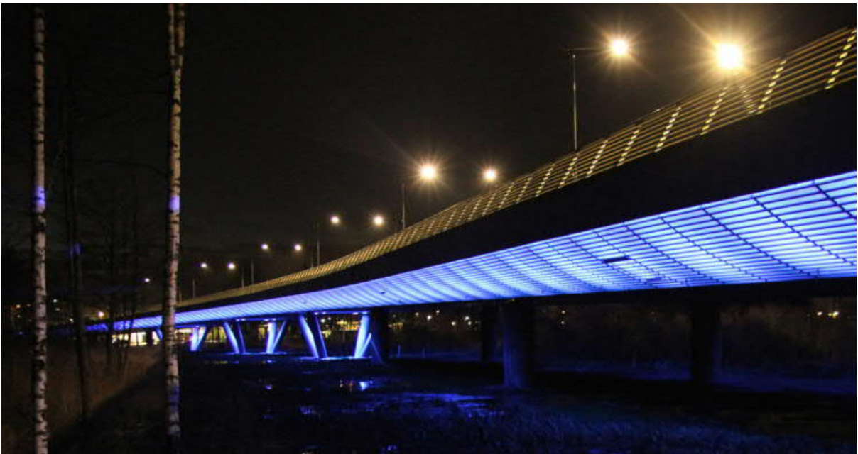
Finnevikin silta Espoo WSP 2016. WSP sai vuoden Silta 2016 -palkinnon suunnittelemastaan Finnevikinsillasta Espoossa. Suomen Rakennusinsinöörien Liiton (RIL) mukaan Finnevikinsilta täytti parhaiten tämän vuoden teeman kriteerit eli elinkaarinäkökulman siltasuunnittelussa. Siltasuunnittelu WSP. Arkkitehtisuunnittelu Tuomas Vuorinen.
