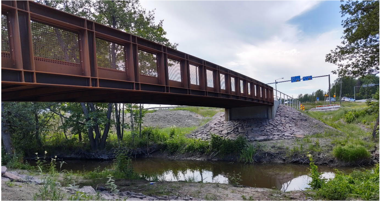
Mankinjoen kevyenliikenteen silta. Espoo 2020. Siltasuunnittelu Olli Perälä.
