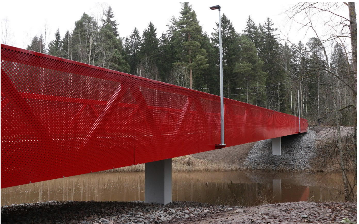
Matarinpuiston silta . Vantaa. 2020. Siltasuunnittelu Olli Perälä. WSP.
