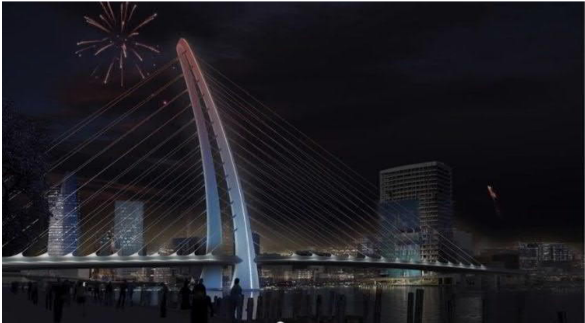
Dragon Bridge Vietnam. Kilpailuehdotus 1 palkinto, voitti siltakilpailun Ho Chi Minh Cityyn 2009. 900 m pitkä vinoköysisilta muodostaa uuden urbaanin maamerkin nykyisen kaupungin ja uuden Thu Thiem II kaupunginosan välille. Pyloni kohoaa 95 m sillan kannen yläpuolelle. Vaalea siltajulkisivu ja pyloni valaistaan öiseen aikaan elävällä led-valaistuksella. Arkkitehtisuunnittelu Tuomas Vuorinen, Siltasuunnittelu Olli Perälä. WSP 2009.
